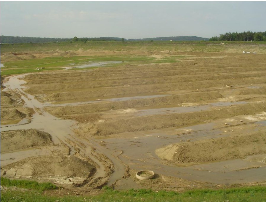
Abbildung 1: Haufwerke/Mieten im Oberbecken (Sommer 2011).
