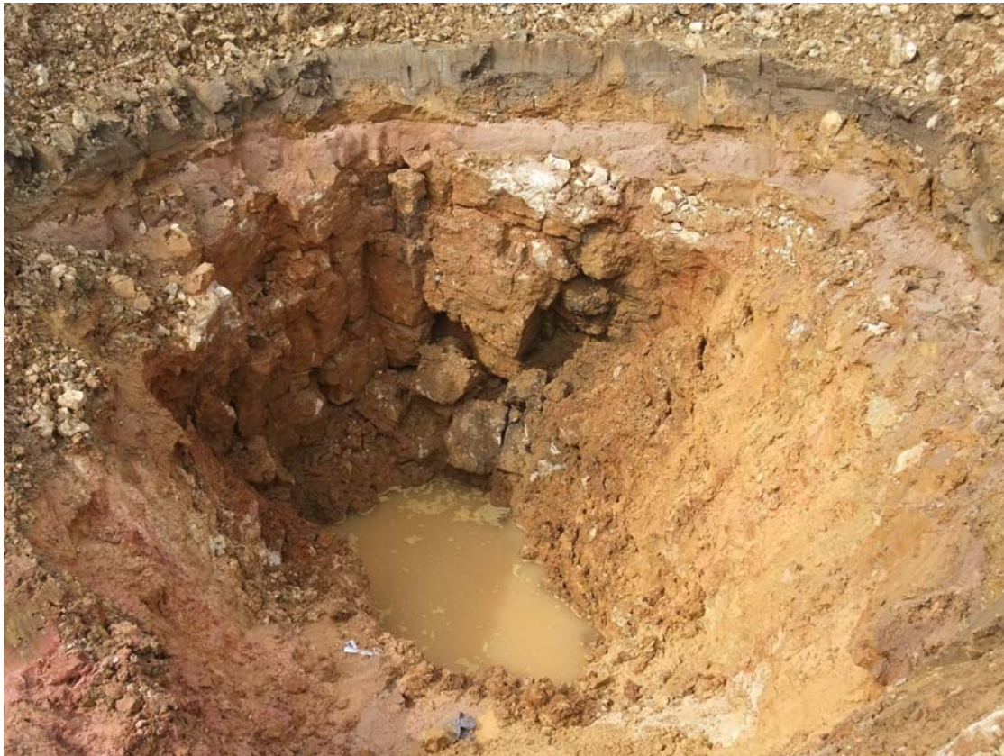
Bild 7.6 Großschurf am Einbruch 8: sandige Lockergesteine im Kontakt zu einer im Norden anstehenden stark klüftigen Kalksteinformation (Wasser an der Sohle aus Stauwasserauf Beckendichtung zugetreten)
