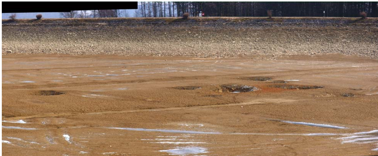
Bild 16: Aufnahme vom 01.03.2011, Blick von Südwesten
