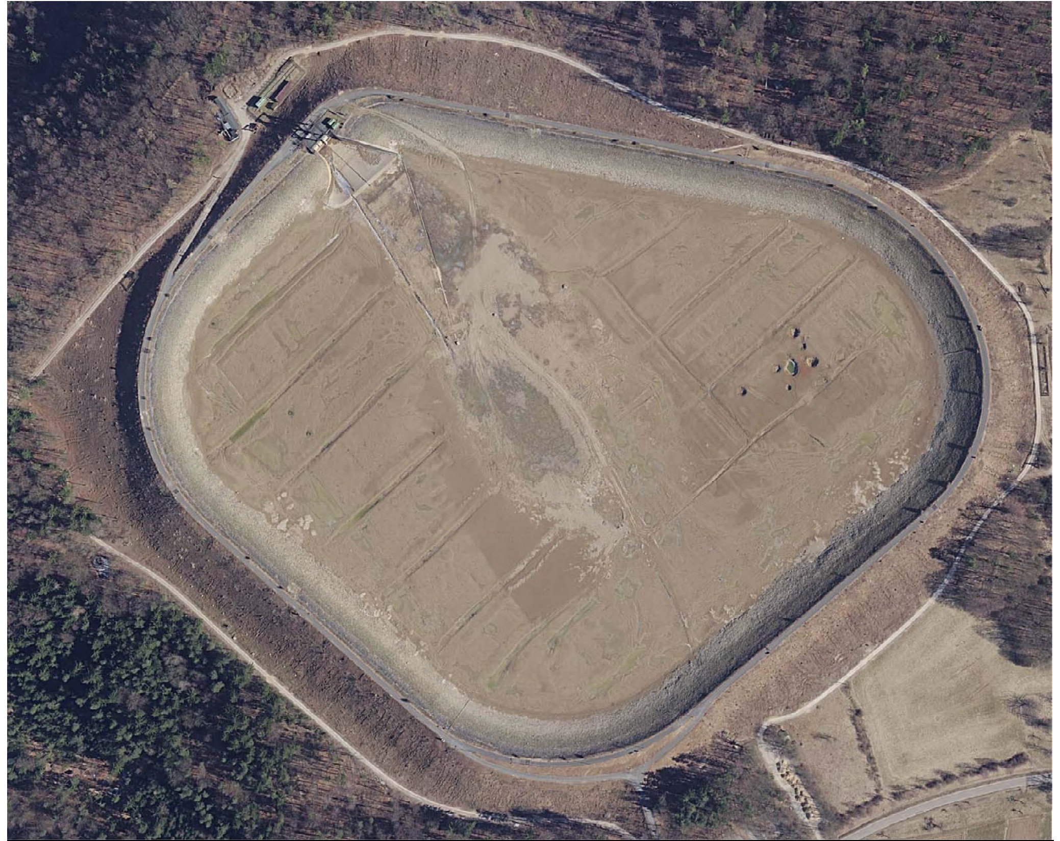
Anlage 2..2: Luftbild des Oberbeckens nach Eintritt der Einbrüche im Januar 2011
