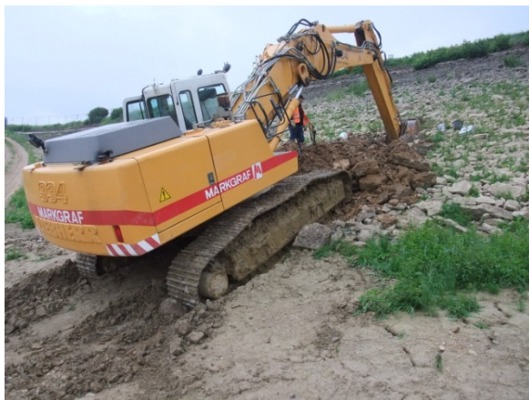
Bild 7.14 Ausführung der Plattendruckversuche in der wasserseitigen Böschung des Ringdamms
