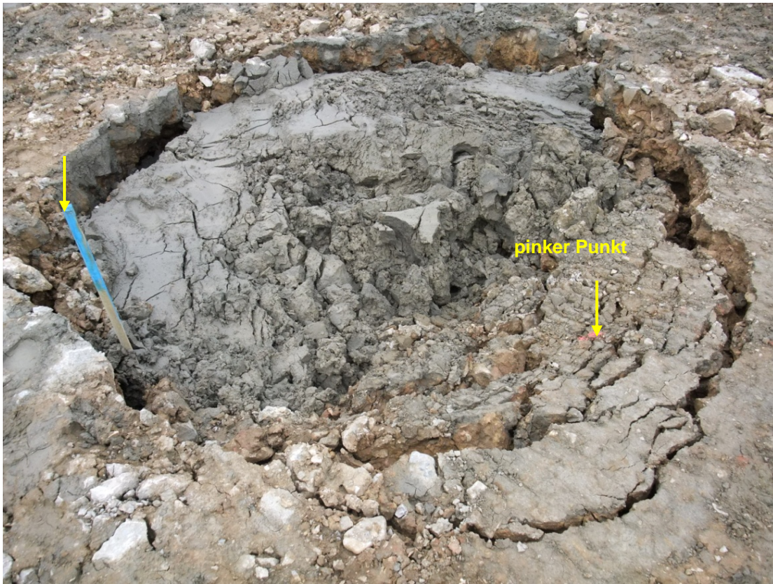
Bild 22: Blick am 28.04.2011, 10:05 Uhr, von Süden auf den neuen Einbruch 17
