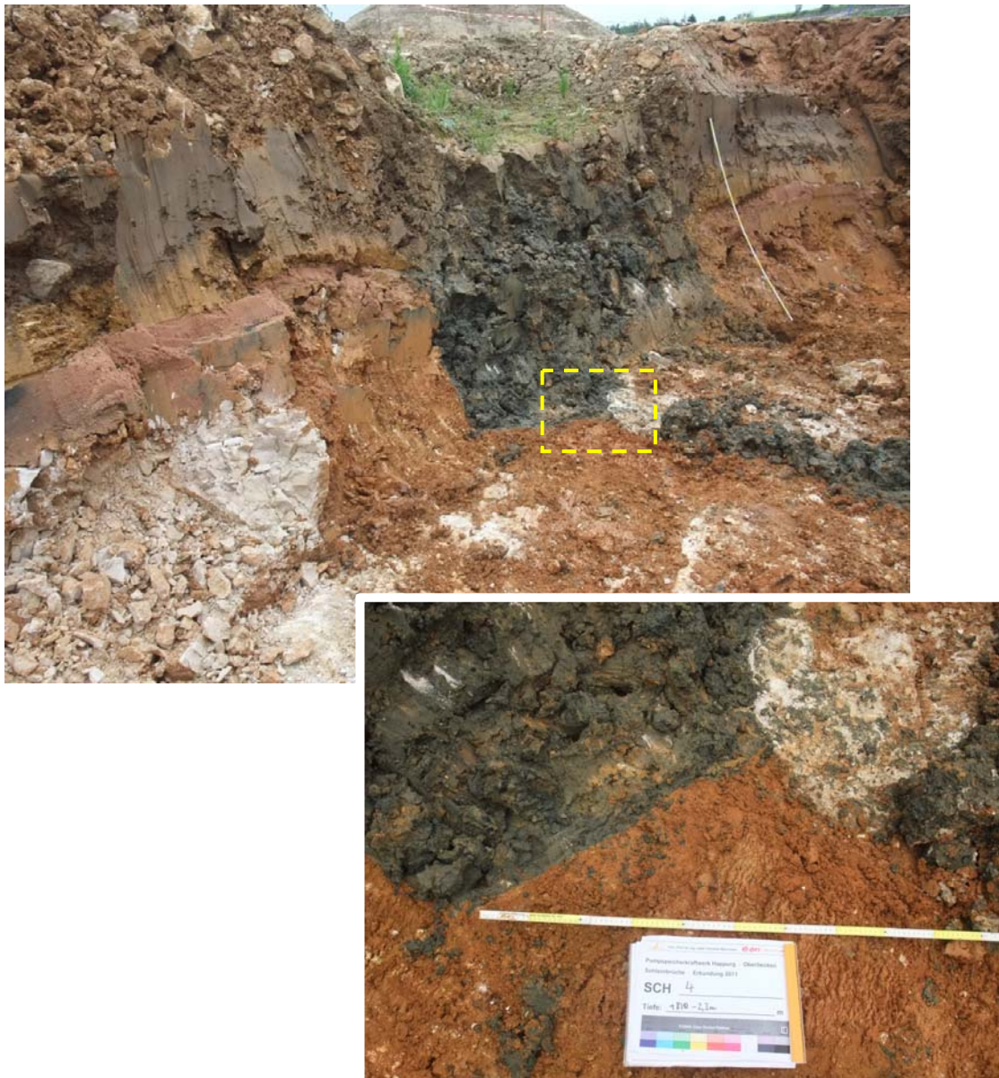
Bild 7.11 Einbruchtrichter 4 im Anschnitt, in Nahfeld Kalksteininformationen und Lockergesteine kleinräumig variierend
