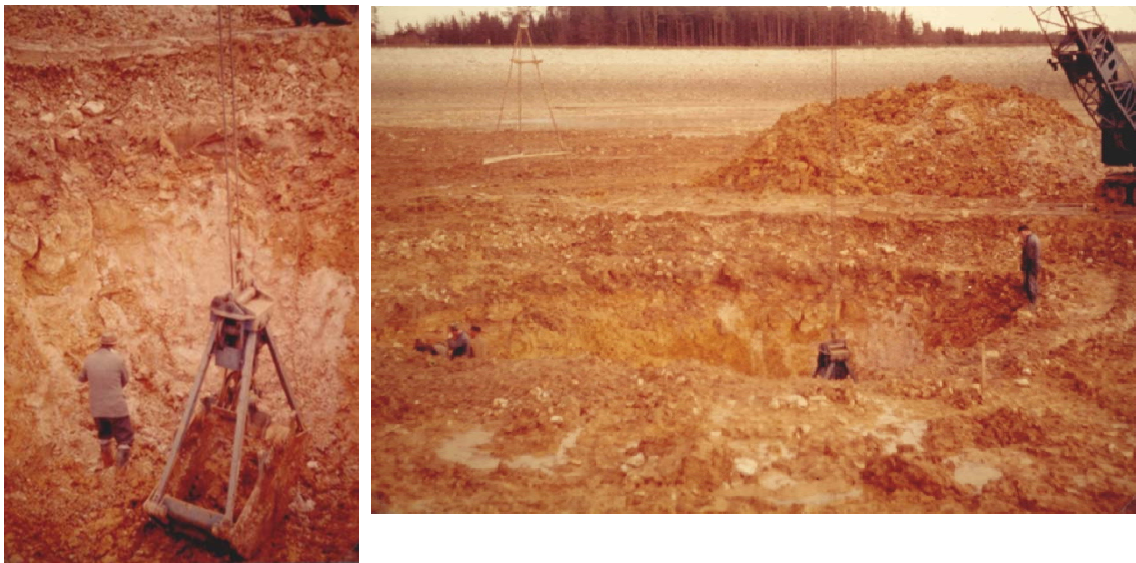
Bild 5.4: Freilegen einer Einbruchstelle im November 1960
