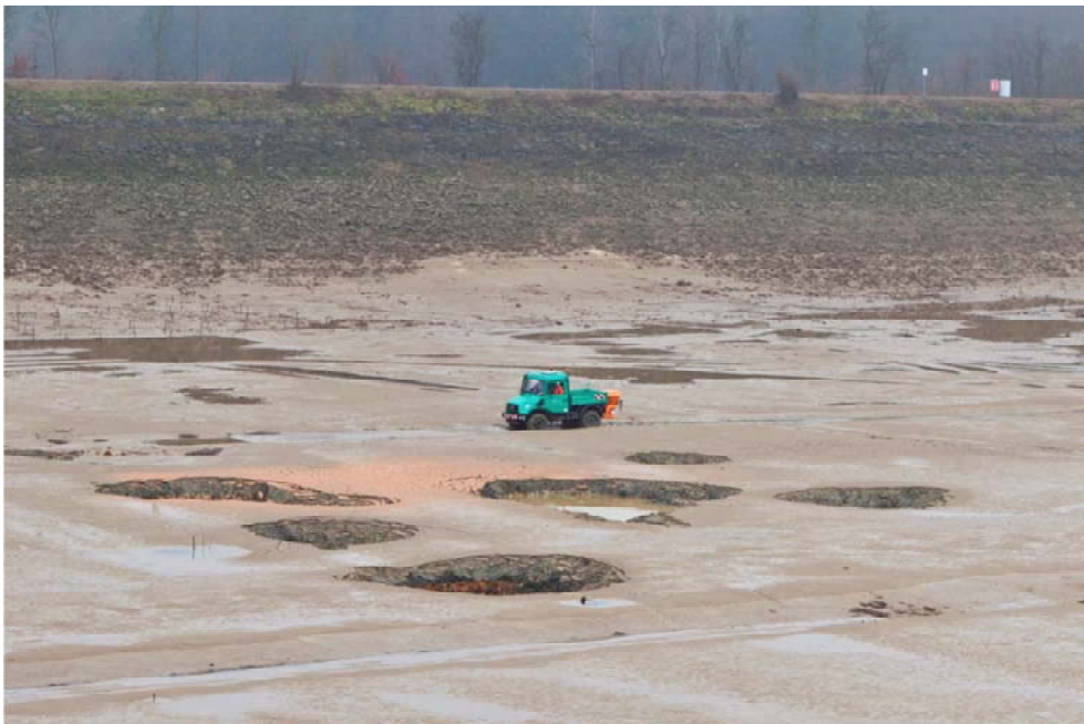
Bild 1.1: Einbrüche im südöstlichen Bereich des Beckens, Aufnahme vom 19.01.2011
