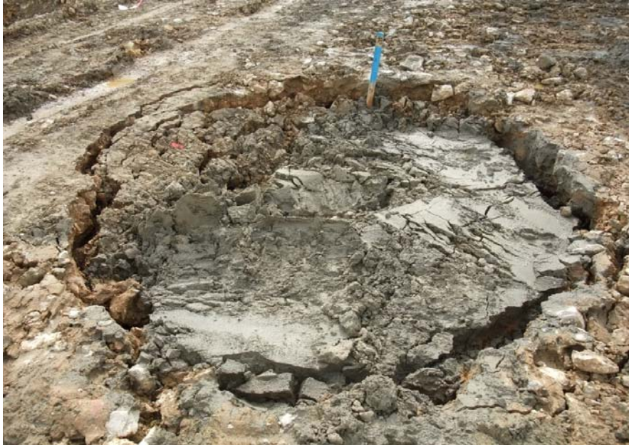
Bild 4.4: Im April 2011 eingetretener Einbruch 17 am 29.04.2011
