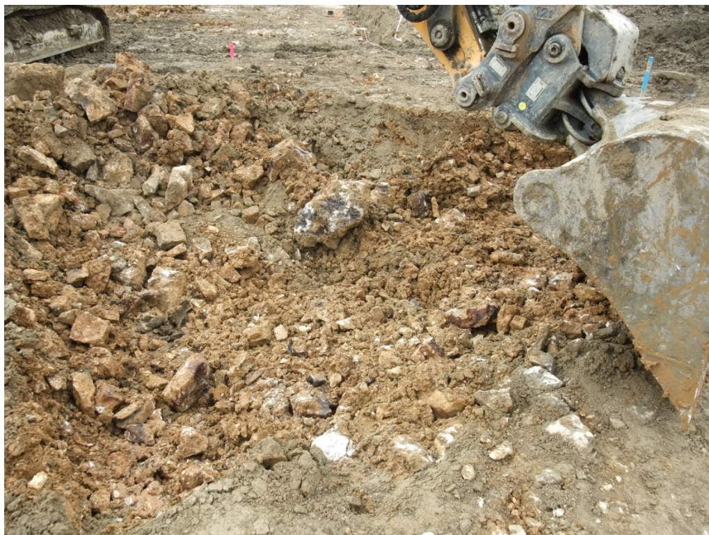
Bild 5: Abräumen der Schutzschicht
