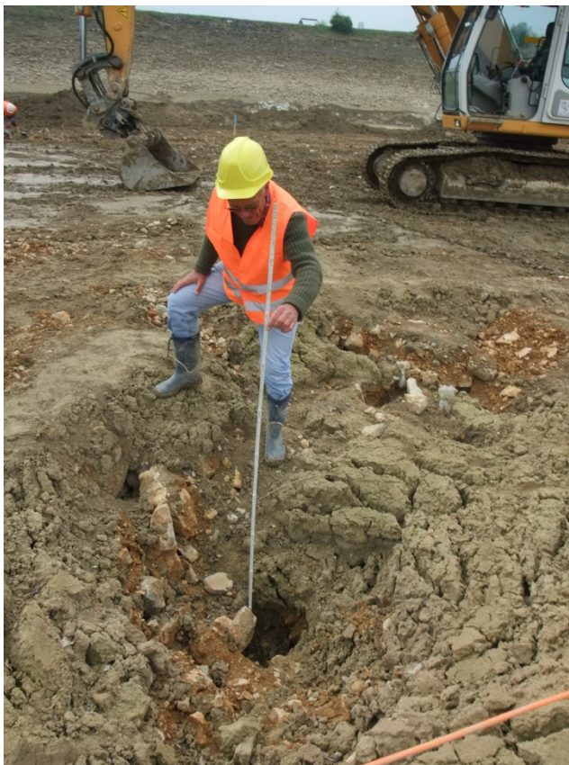
Bild 4: Einmessen der Tiefe des Trichters vor Beginn Schurfarbeiten
