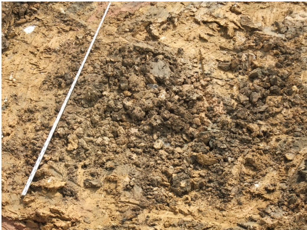
Bild 12: Detailaufnahme Einbruchtrichter nach Abräumen der Lehmdichtung aus Tallehm
