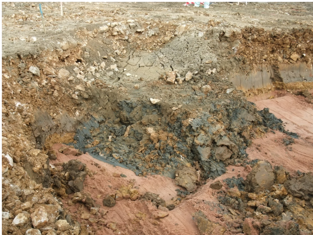
Bild 14: Einseitiges Freilegen des Einbruchtrichters 3
