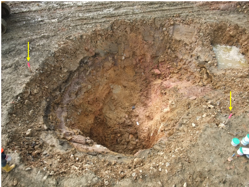
Bild 33: Blick auf Aushub -4,7 m
