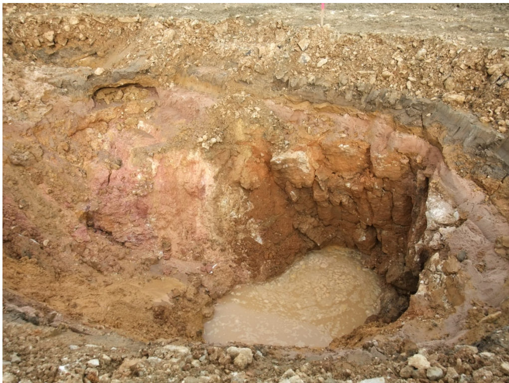
Bild 35: am 29.04.2011: zwei Tage nach Schurferstellung: Oberflächenwasser hat sich in Schurf gesammelt
