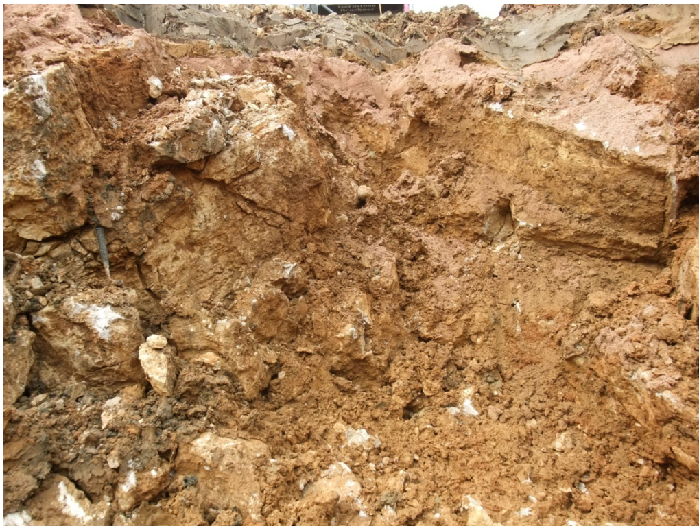
Bild 29: Aushub -5,3 m: offensichtlich teilweise verstürzte Kalksteinformation in der nördlichen Schurfwandung
