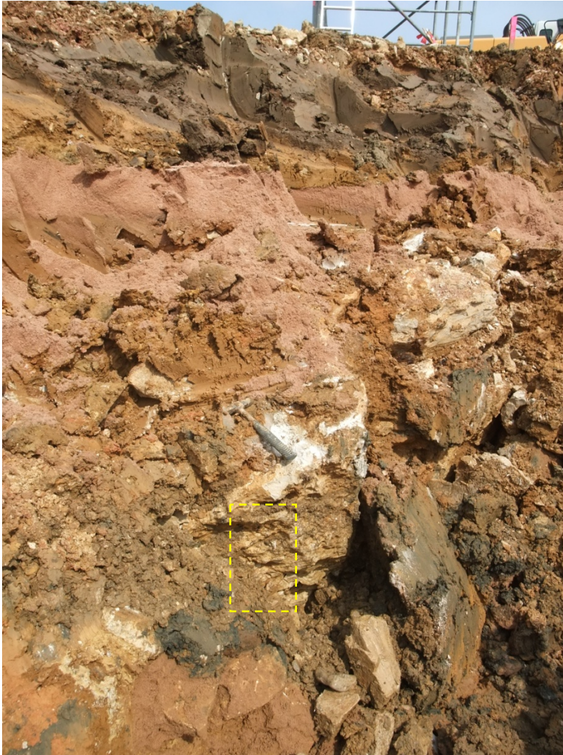
Bild 9: Aushubniveau -2,0 m, im Norden Antreffen von Kalksteinblöcken rd. 30 cm unter UK Filtersand, markierter Ausschnitt in Bild 10 dargestellt
