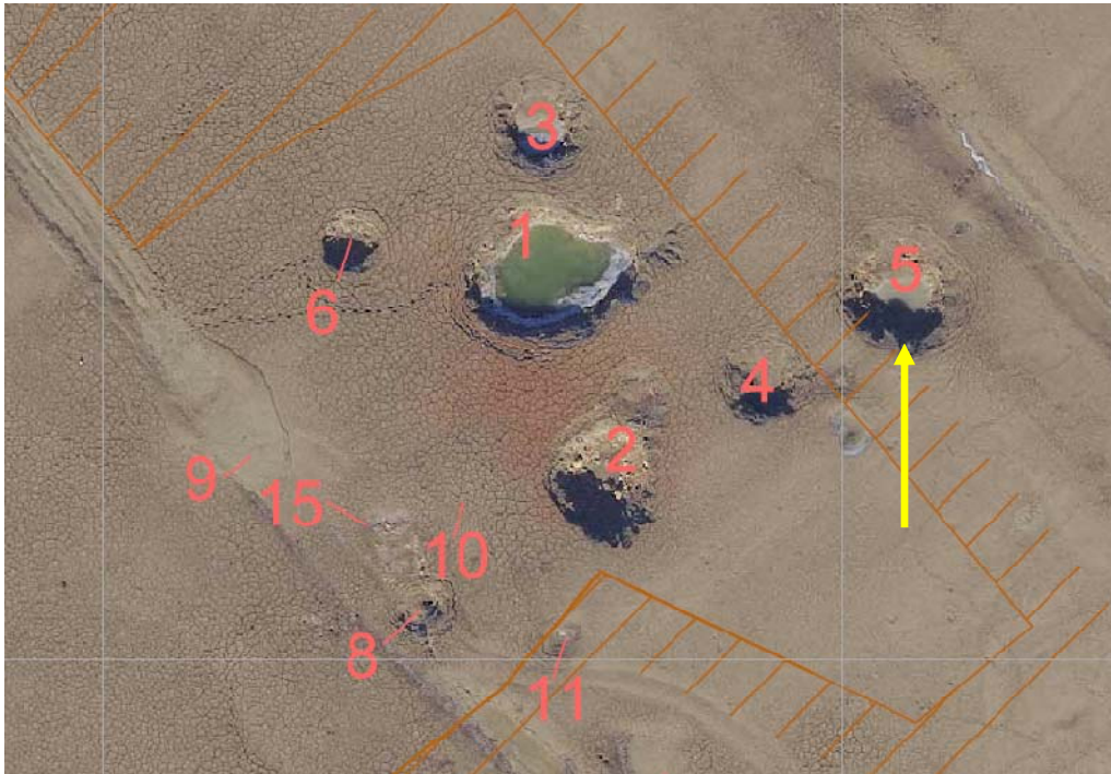
Bild 1: Lage des Einbruchtrichters 5 (Luftbild, Ausschnitt, Quelle: Fichtner/e.on)
