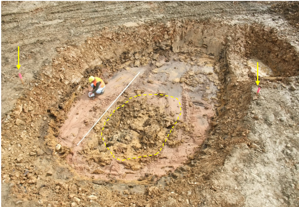
Bild 17: Blick von Nordwesten auf Einbruchtrichter nach Abräumen der Lehmschicht aus Oberbecken, außerhalb des Einbruchtrichters unterliegend Filtersand, im Einbruchtrichter eingebrochene Lehmdichtung (?) und Reste Schutzschicht
