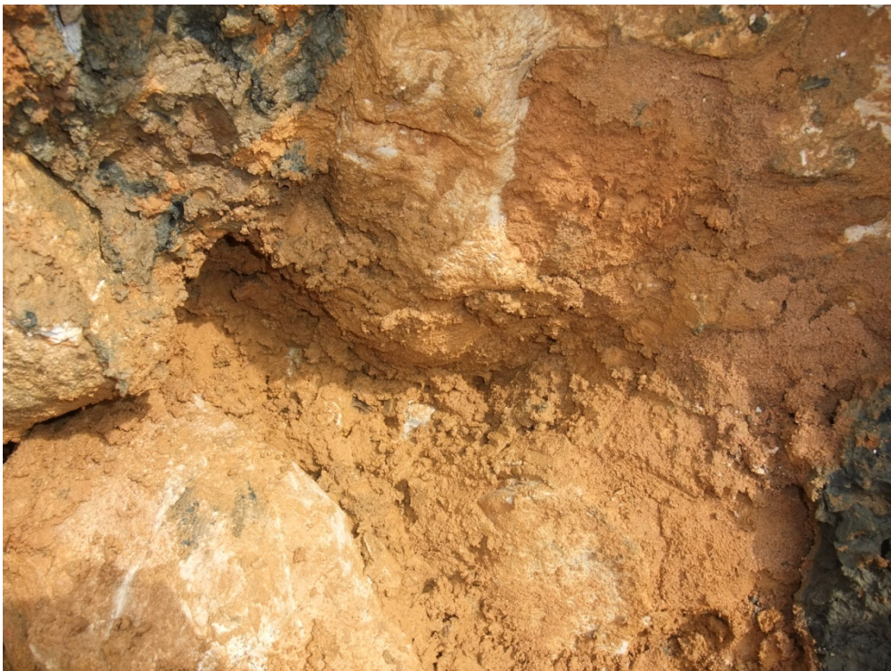
Bild 14: Aushubniveau -2,0 m: in Spalten und Klüfte der Kalksteinblöcke eingetragener Filtersand und dunkles aufgeweichtes Material (Beckensediment?)
