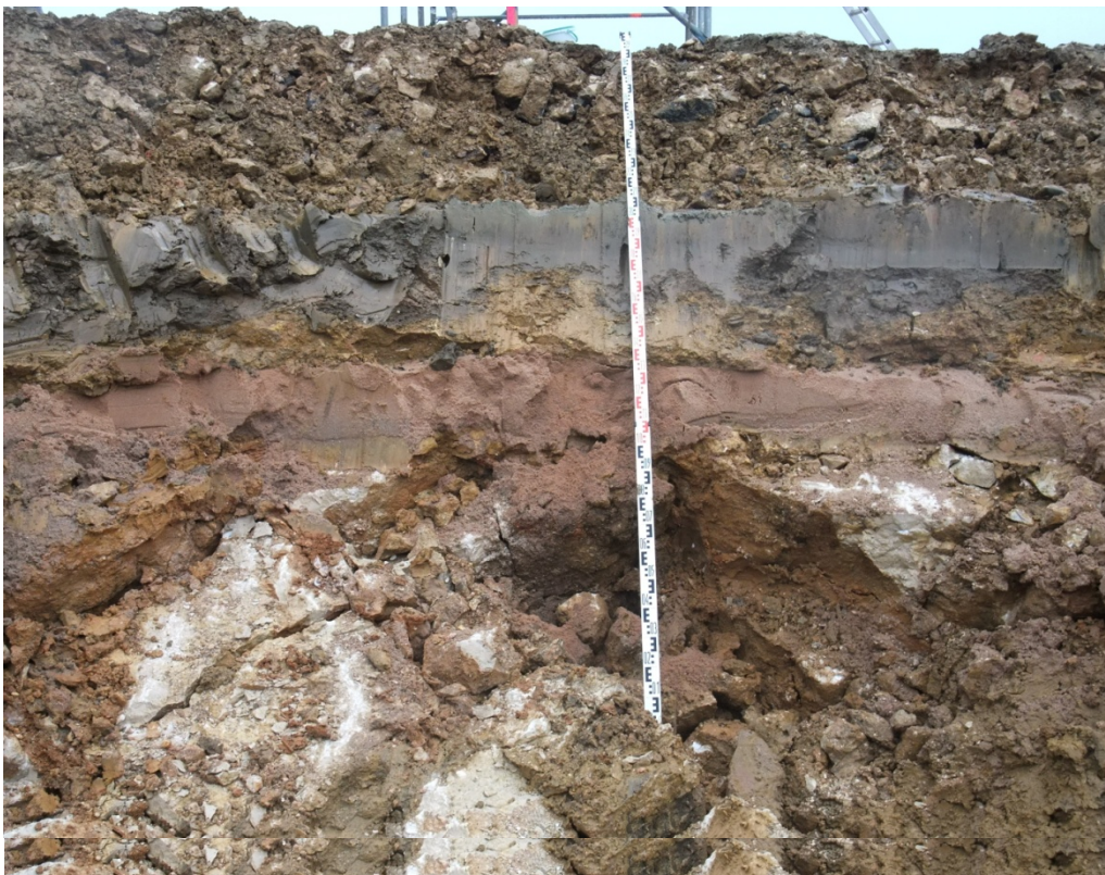
Bild 22: im Norden von ET 8 lagert die Sohlendichtung unmittelbar auf Kalkstein
