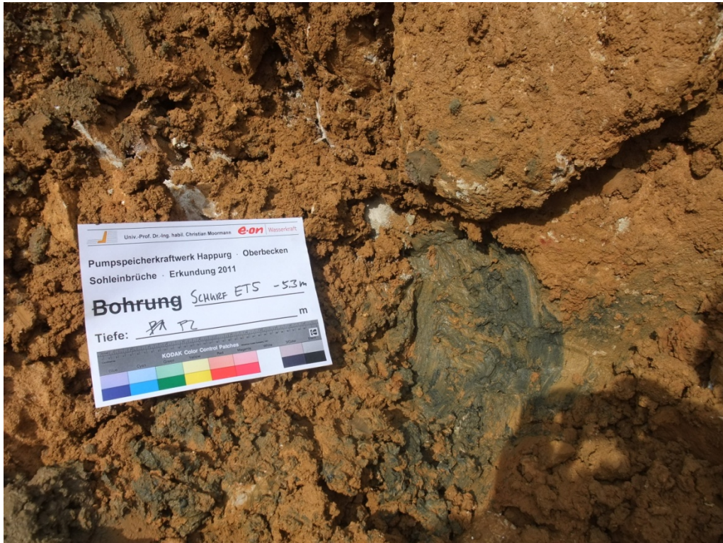
Bild 25: Aushub -5,3 m: weiterhin dunkelgraues und schwarzes aufgeweichtes, tlw. organisches Material im Einsturztrichter und in Kontaktzone zu Kalkstein
