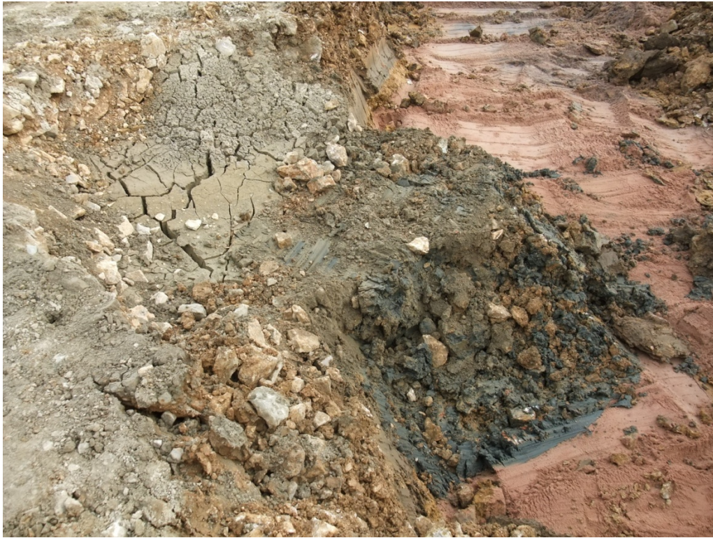
Bild 15: Einseitiges Freilegen des Einbruchtrichters 3
