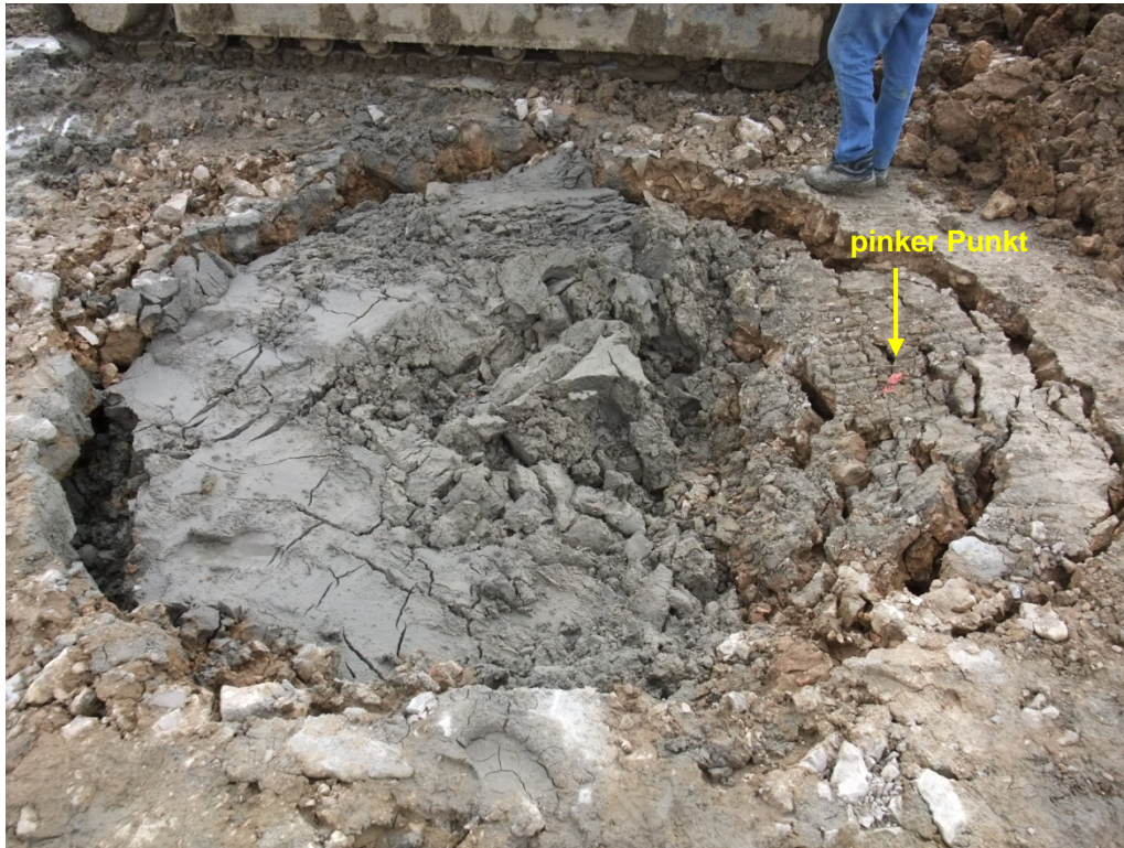
Bild 5: Blick am 29.04.2011 von Süden auf den neuen Einbruchtrichter 17
