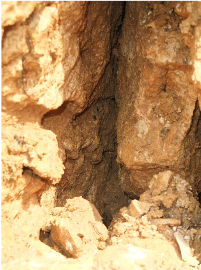
Bild 13: Aushubniveau -2,0 m: Blick in offene Spalte zwischen den im Norden des Schurfs anstehenden Kalksteinblöcken
