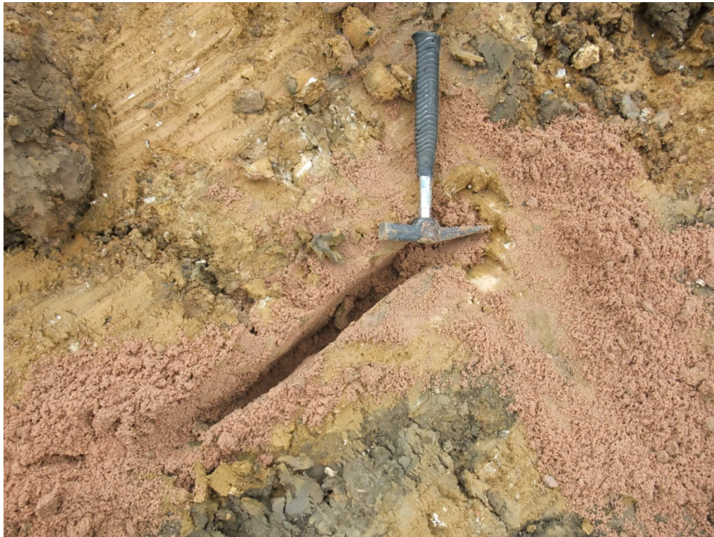
Bild 15: mit Filtersand gefüllte Spalte in Lehmschicht aus Oberbecken
