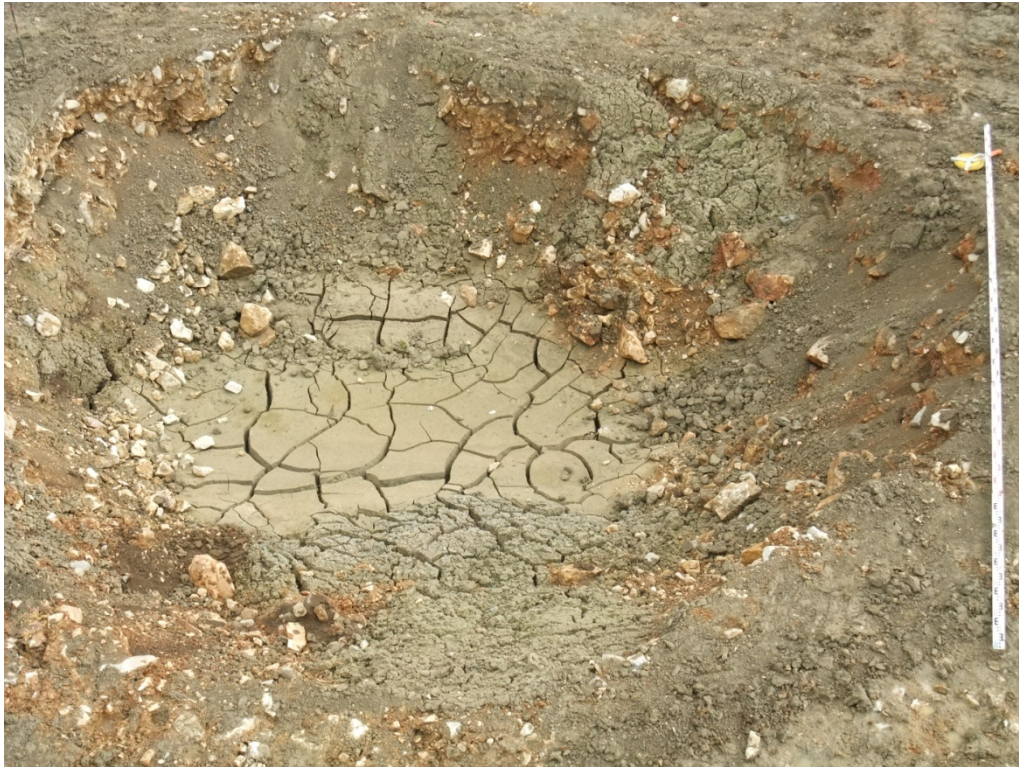
Bild 3: Detailaufnahme von Nordwesten auf Einbruchtrichter 5 vor Beginn der Schürfarbeiten
