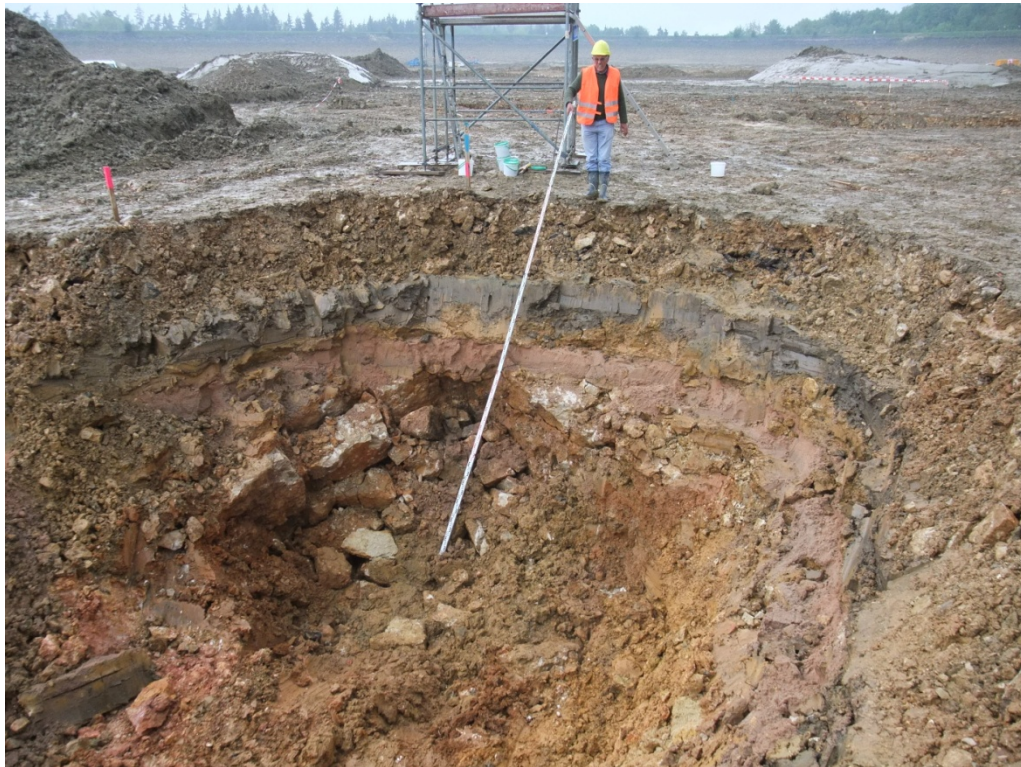
Bild 23: ET 8 Blick Richtung Norden, Aushub -3,7 m
