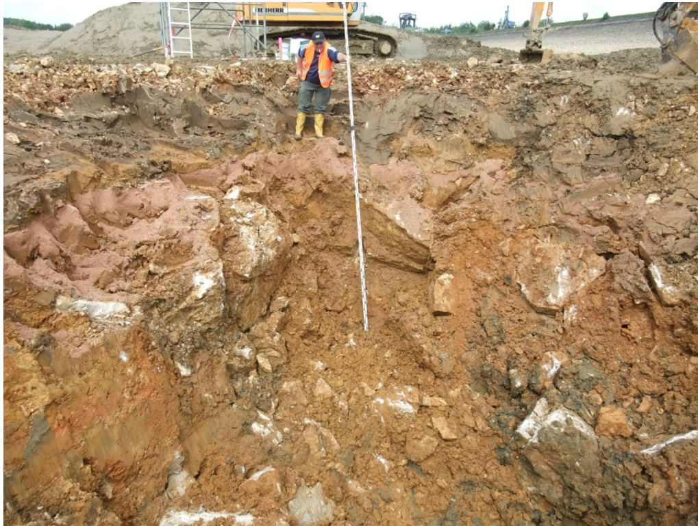
Bild 21: Aushub -5,0 m: Blick nach Norden mit verstärzter Kalksteininformation
