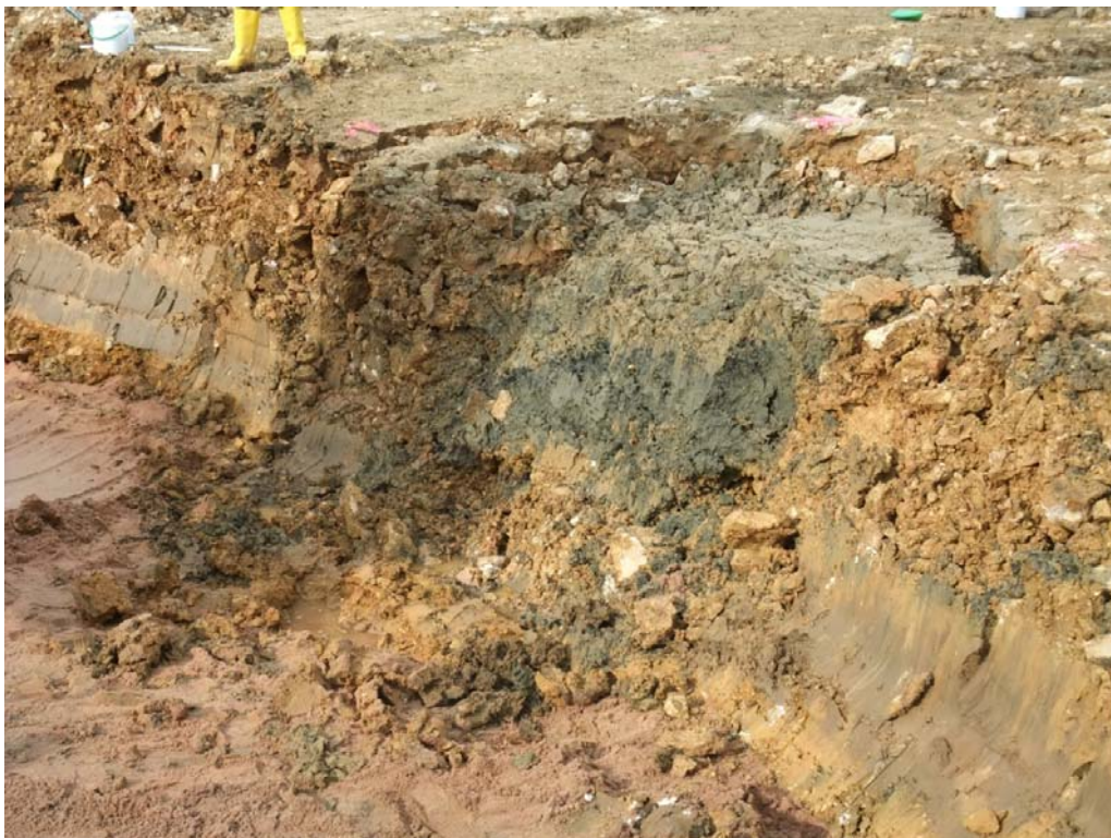
Bild 12: seitlich freigelegter Einbruchtrichter 17: abgesacktes schwarzes Beckensediment
