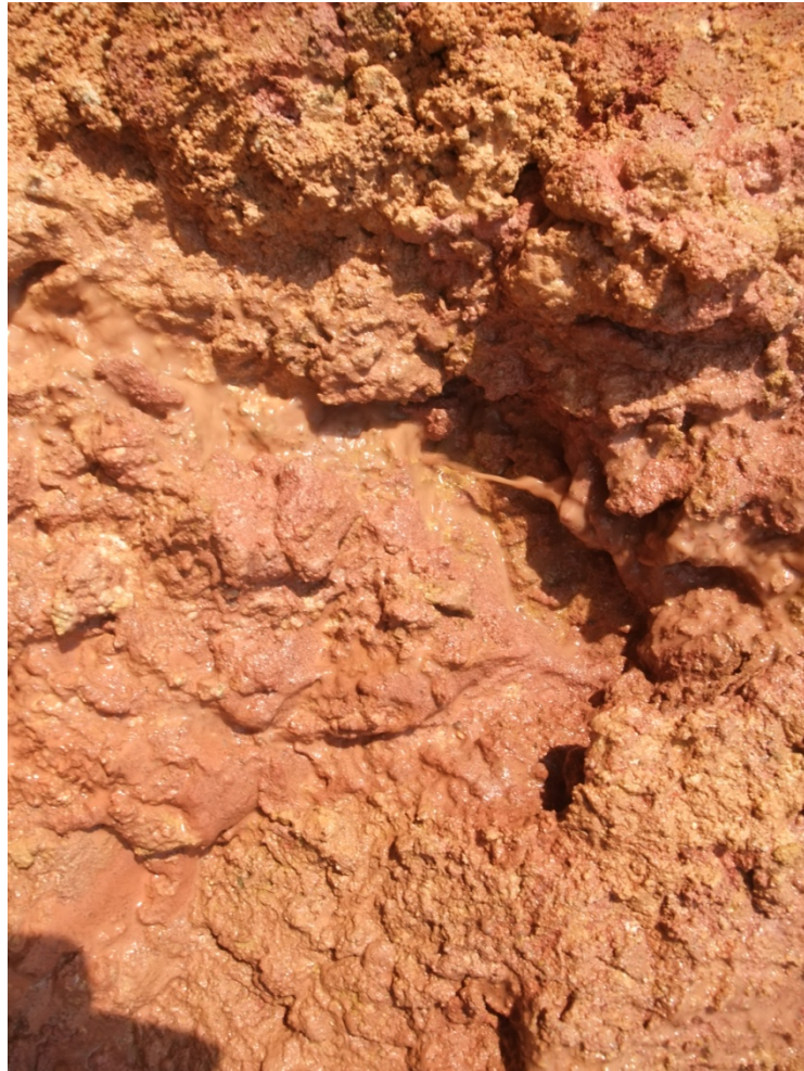
Bild 32: Aushub -4,7 m, westliche Schurfwandung: kreidezeitliche Sande und Schluffe werden durch oberflächennahen Wasserzutritt rasch erodiert
