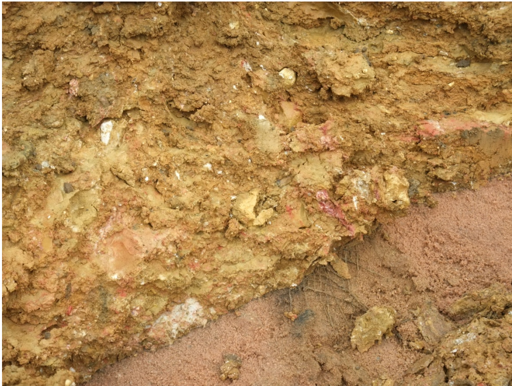
Bild 13: Detailaufnahme Lehm aus Oberbecken, darunter rötlicher Filtersand, eingelegte Jute-Matte erkennbar
