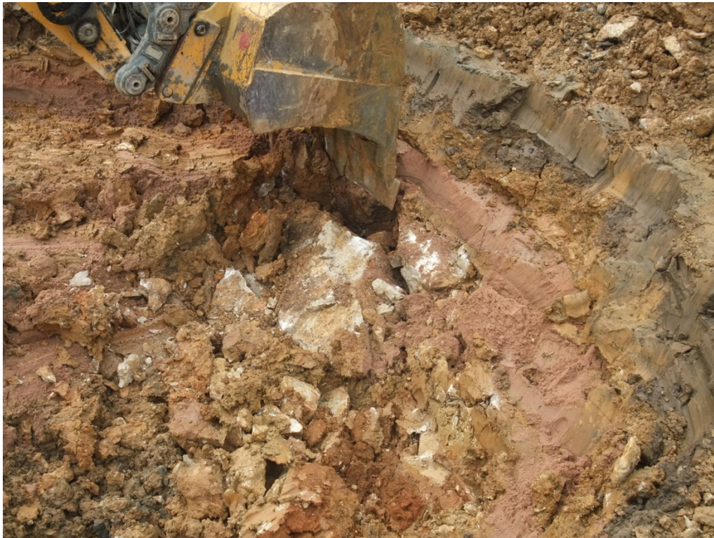
Bild 21: im Norden von ET 8 Antreffen von Kalkstein unmittelbar unter Filtersand
