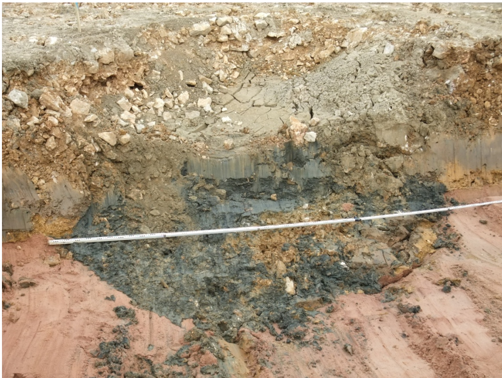
Bild 16: Einseitiges Freilegen des Einbruchtrichters 3: scharfer Übergang zwischen eingebrochenen Beckensediment und Schutzschicht zu umgebenden Filtersand
