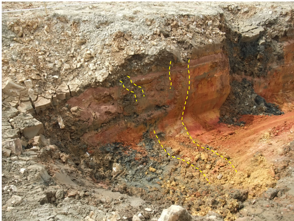
Bild 48: Aushub -3,4 m, Ansicht Einbruchtrichter 1 im Anschnitt: Staffelbruch mit mehrfach versetzter Filtersandschicht, im Tiefsten unverändert schwarzes weiches Material
