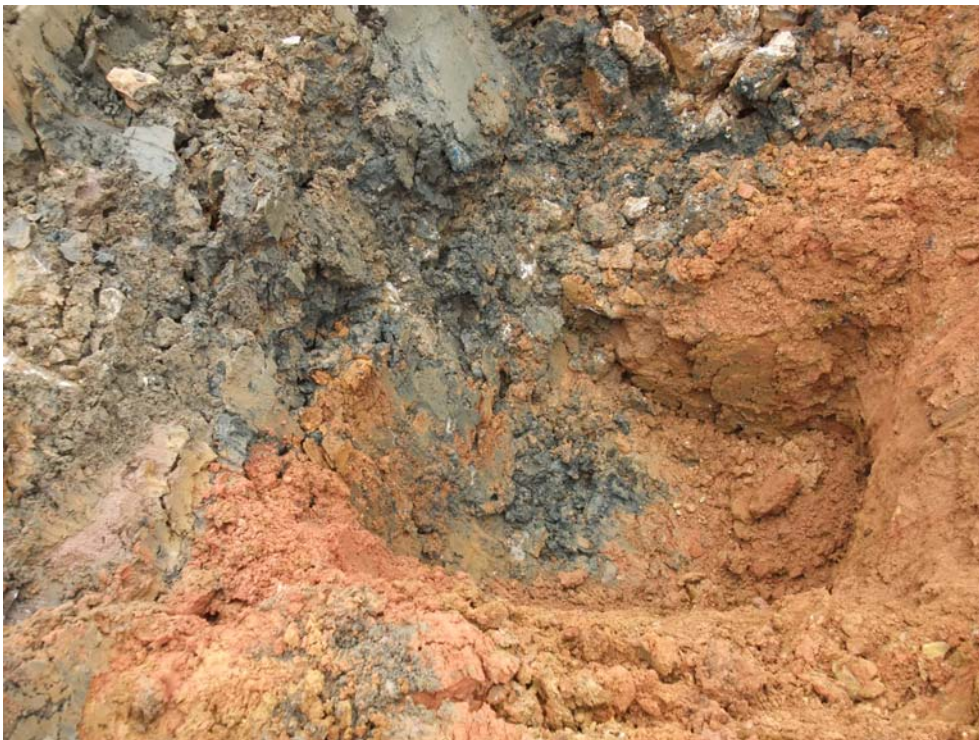
Bild 32: Blick in den auf knapp -6 m unter Beckensohle vertieften Schurf am Einbruch 2: dunkles bindiges organisches Material im Einbruch bis Endtiefe des Schurfs
