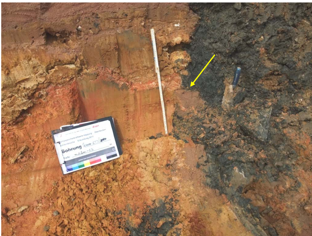
Bild 32: Aushub -2,3 m, südlicher Rand Einbruchtrichter 3: mitgerissener Teil des Filtersandes
