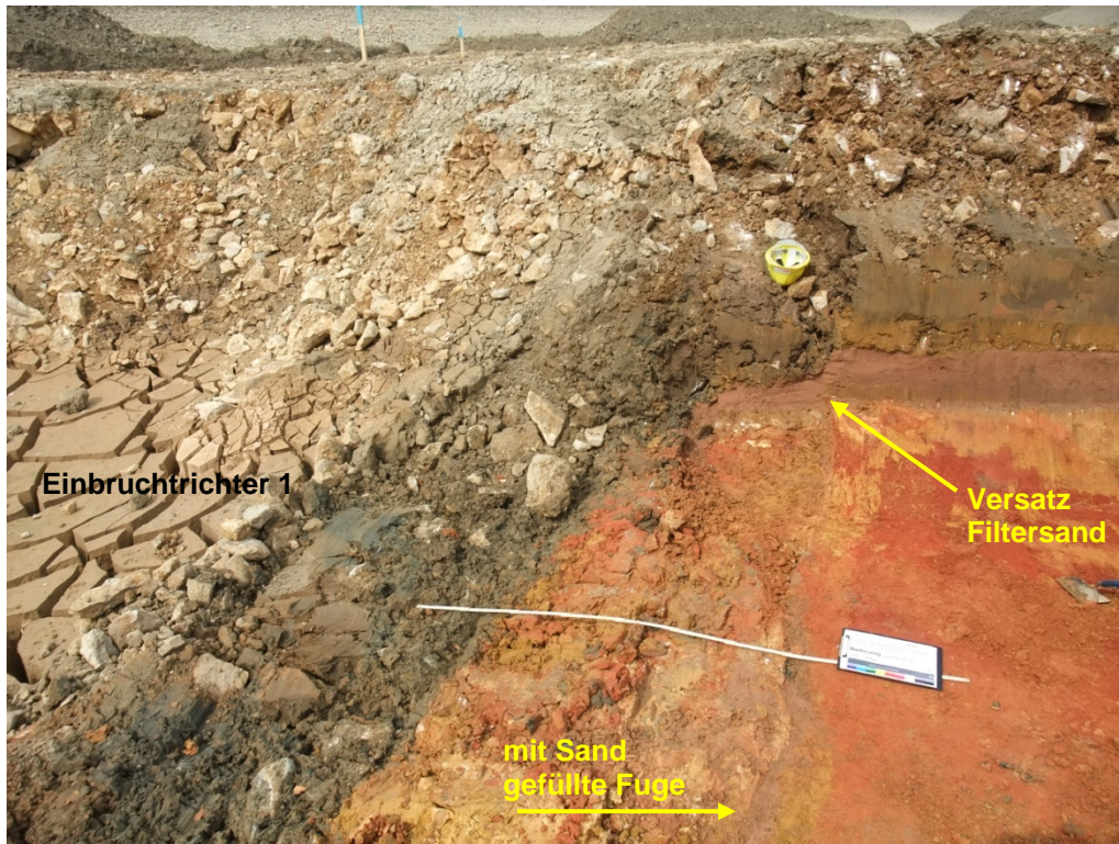
Bild 23: Aushub -1,9 m, nördlicher Rand Einbruchtrichter 1: ca. 1 m breiter Staffelbruch mit Versatz im Filtersand und sandgefüllter Spalte in kreidezeitlichen Sedimenten
