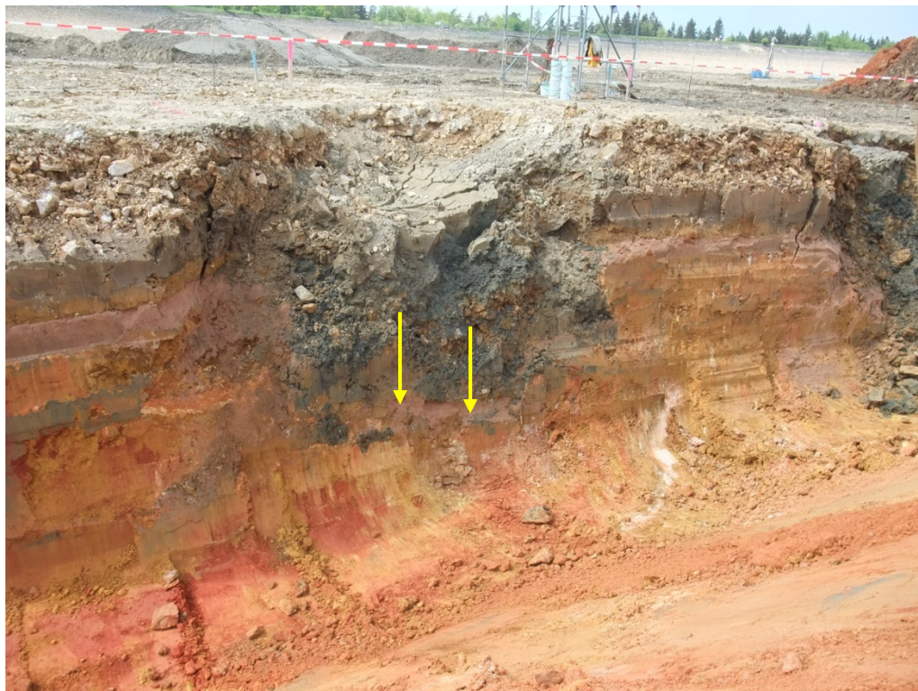
Bild 46: Aushub -3,4 m, Ansicht Einbruchtrichter 3 im Anschnitt: unter abgesackter Filter-sandschicht stehen eindeutig wieder kreidezeitliche Sedimente an
