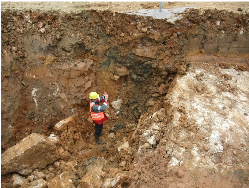
Bild 11: weiterer Aushub, in der Mitte Einbruch 7 (Kernbohrung BK 34/2011 im Zentrum), im Osten (rechts) Kalksteinformation, im Westen Lockergestein mit Kalksteinblöcken
