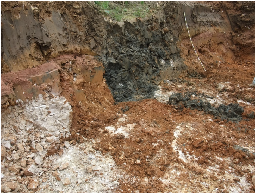
Bild 19: Anschnitt Einbruch 4: kleinräumig wechselnde Abfolge von Kalksteinformationen und Lockergesteinen unter Beckensohle
