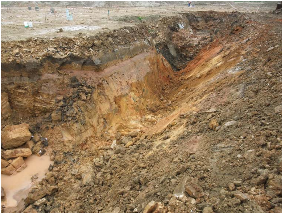
Bild 35: Blick von Südwesten in den Schurf bei Endaushub, im Vordergrund links Einbruch 8, zwischen Einbruch 2 und 4 mit Lockergesteinen (S,u*) verfüllte Versturzzone
