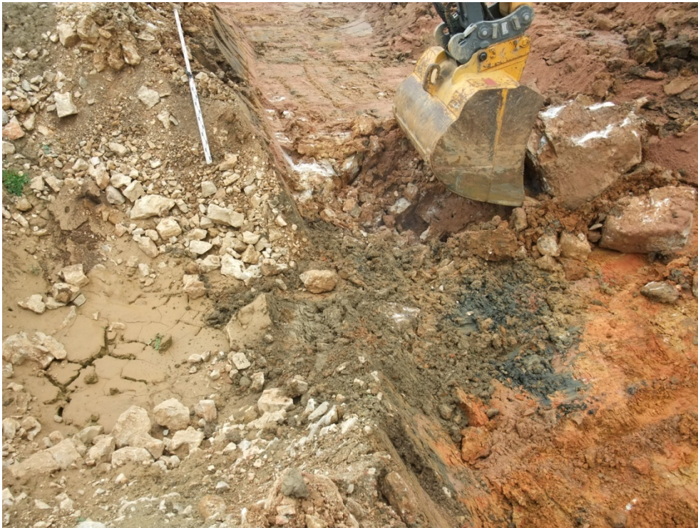
Bild 9: Anschnitt Einbruch 2 (links): Antreffen von Kalkstein unmittelbar unter Dränagesand im Nordosten und von Kreidesanden im Südwesten
