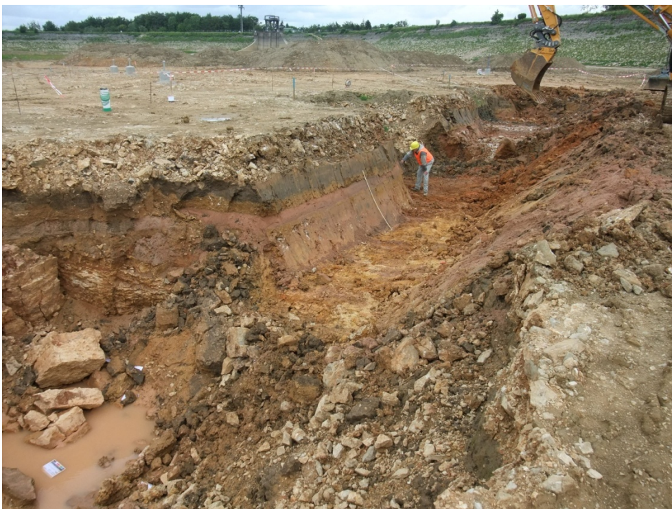
Bild 14: Blick von Südwesten auf Großschurf bei Aushubniveau ca. 2,5 m, im Vordergrund Einbruch 8, in der Mitte Einbruch 2
