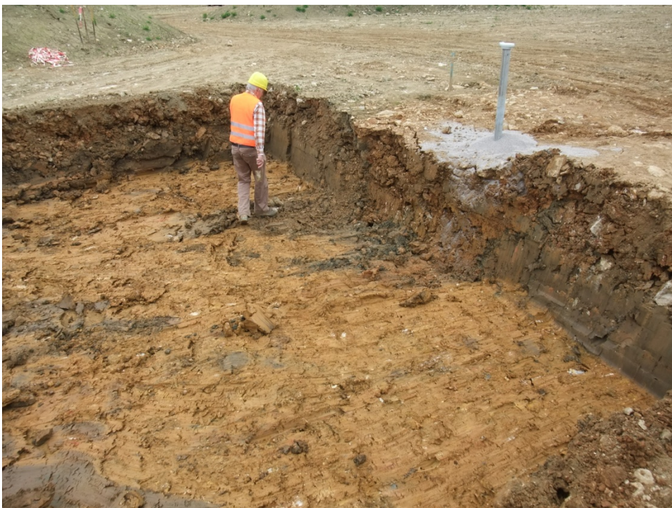
Bild 4: Schurf nach Abtrag der 'Lehmdichtung Tallehm', in der Basis der ockerfarbene 'Lehm aus dem Oberbecken'
