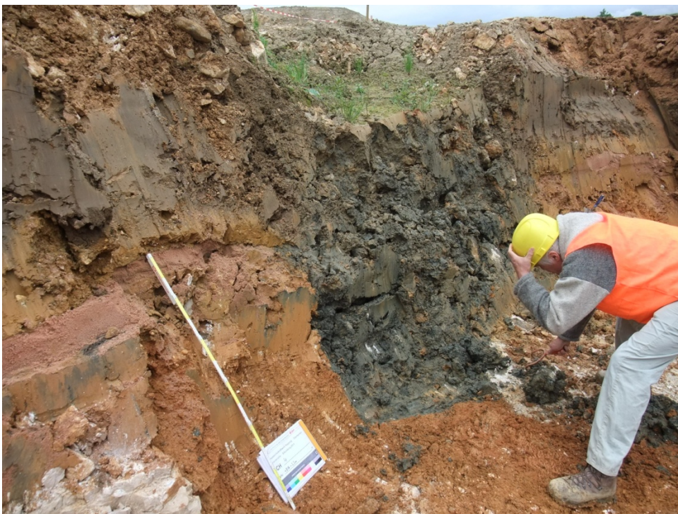
Bild 16: Einbruch 4 im Anschnitt: dunkle weiche organische bindige Böden im Einbruchbereich im Kontakt zu Lockergesteinen und Kalkstein
