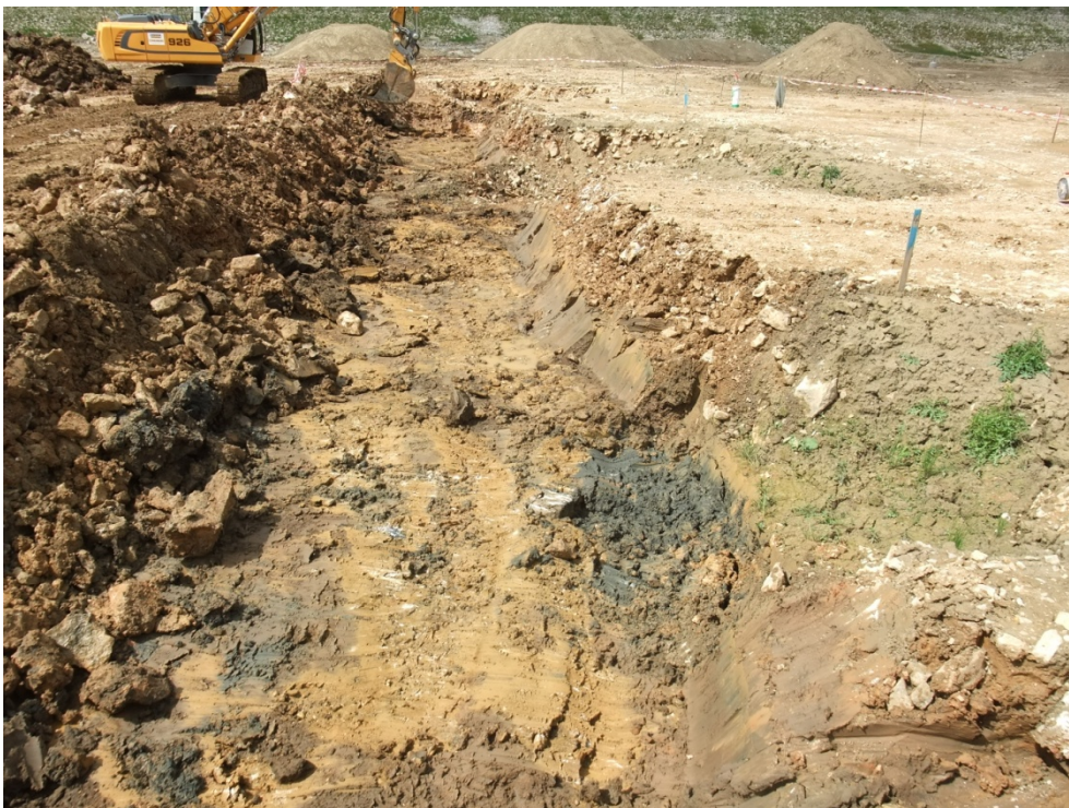
Bild 6: Anlage des Schurfes: Abtrag von Schutzschicht und oberer Abschnitt Lehmdichtung
