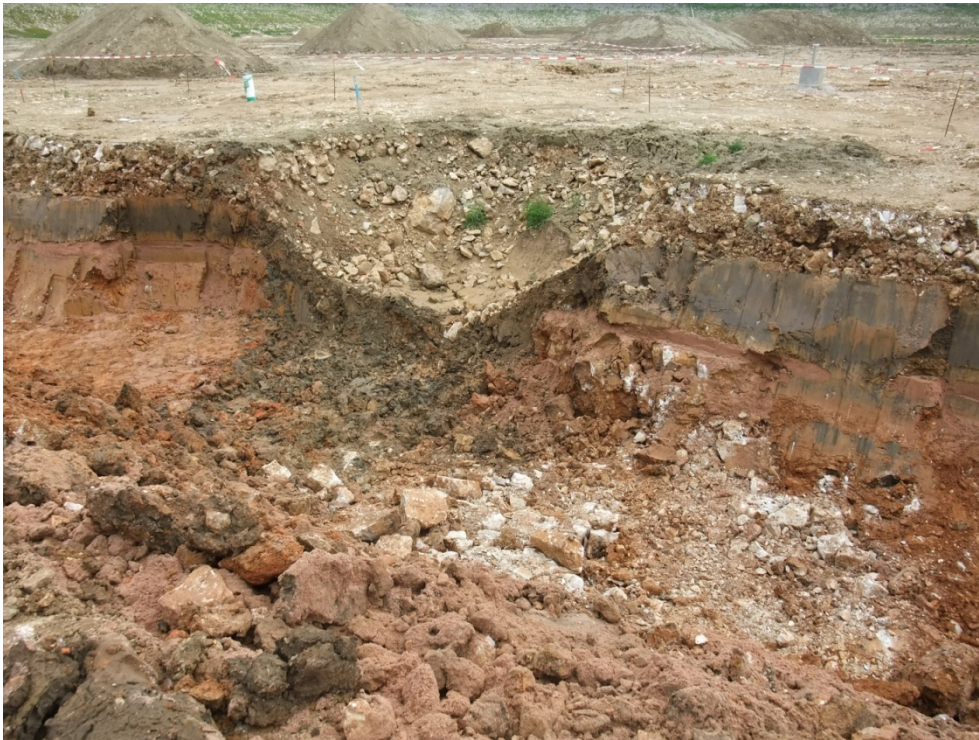
Bild 21: Anschnitt Einbruch 2: Kalkstein im nordöstlichen Bereich und Kreidesanden im Südwesten
