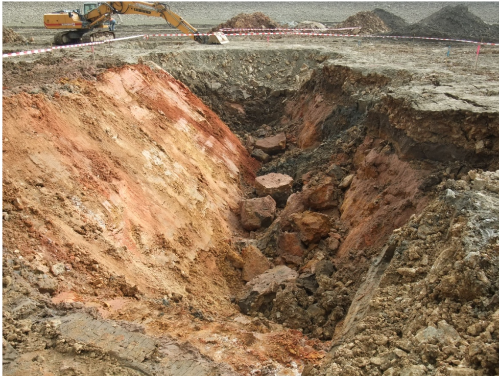
Bild 53: Schurf während des weiteren Aushubs verstürzt auf Grund der geringen Eigenstandfestigkeit der kreidezeitlichen Sedimente
