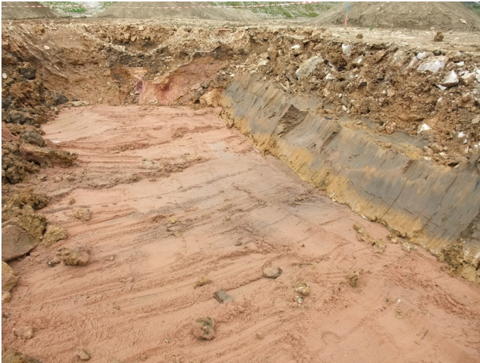
Bild 7: Blick von Nordosten Richtung Einbruch 8 nach Abräumen der Sohldichtung: intakte Sohldichtung im Anschnitt und Dränagesand im Planum
