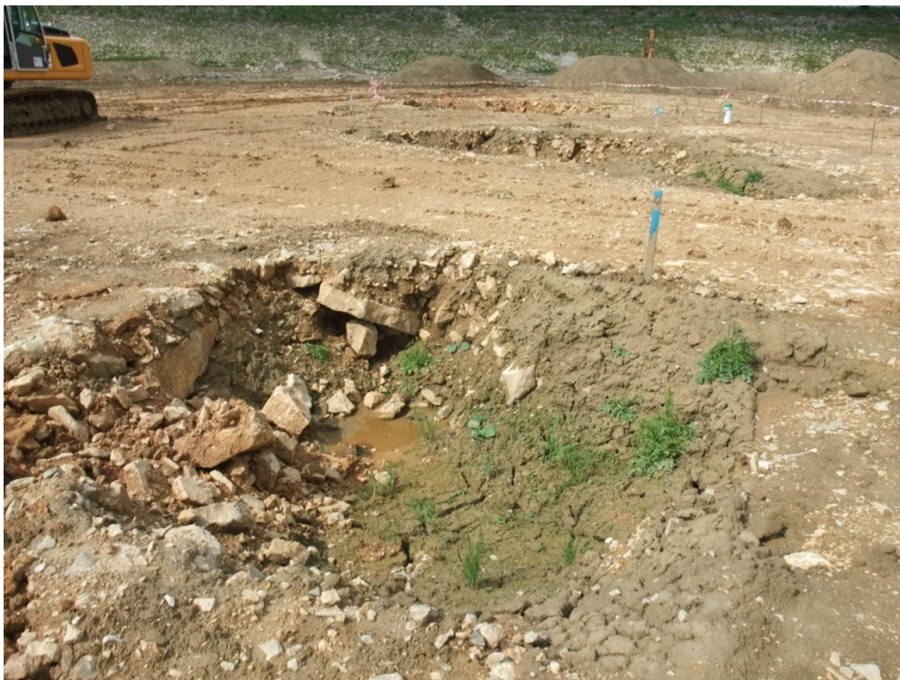
Bild 4: Blick von Nordosten auf Einbruchtrichter 4 vor Beginn der Schürfarbeiten
