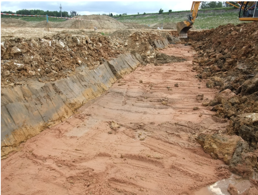
Bild 7: Blick von Nordosten Richtung Einbruch 8 nach Abräumen der Sohldichtung: intakte Sohldichtung im Anschnitt und Dränagesand im Planum
