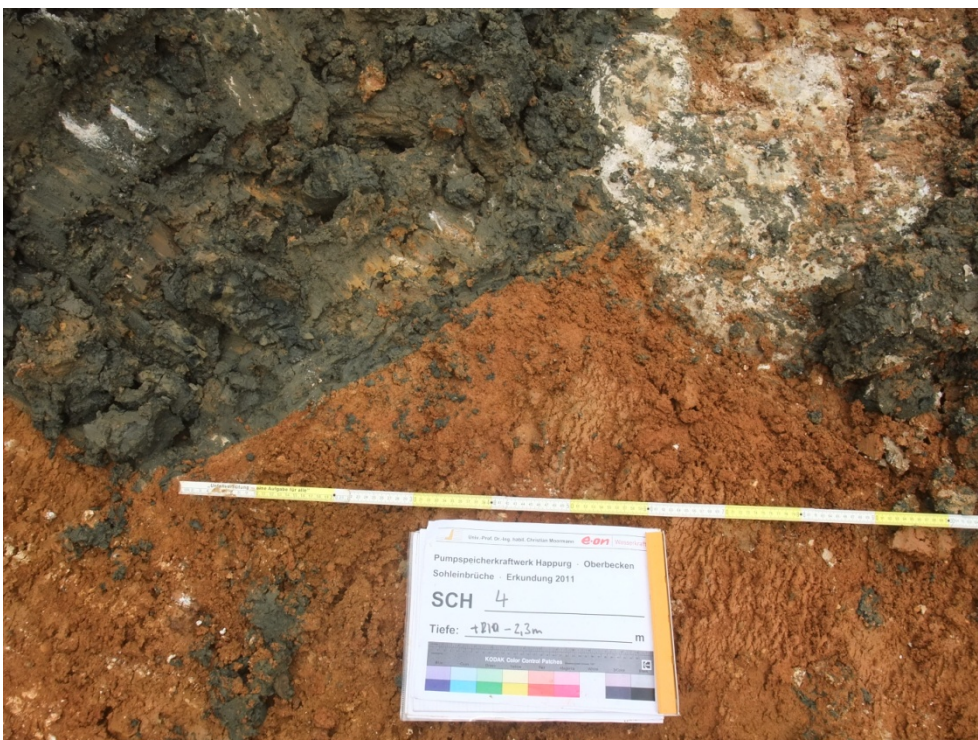
Bild 18: Detailaufnahme vom Einbruchrichter 4: dunkle weiche organische bindige Böden im Einbruchbereich im unmittelbaren Kontakt zu Lockergesteinen und Kalkstein
