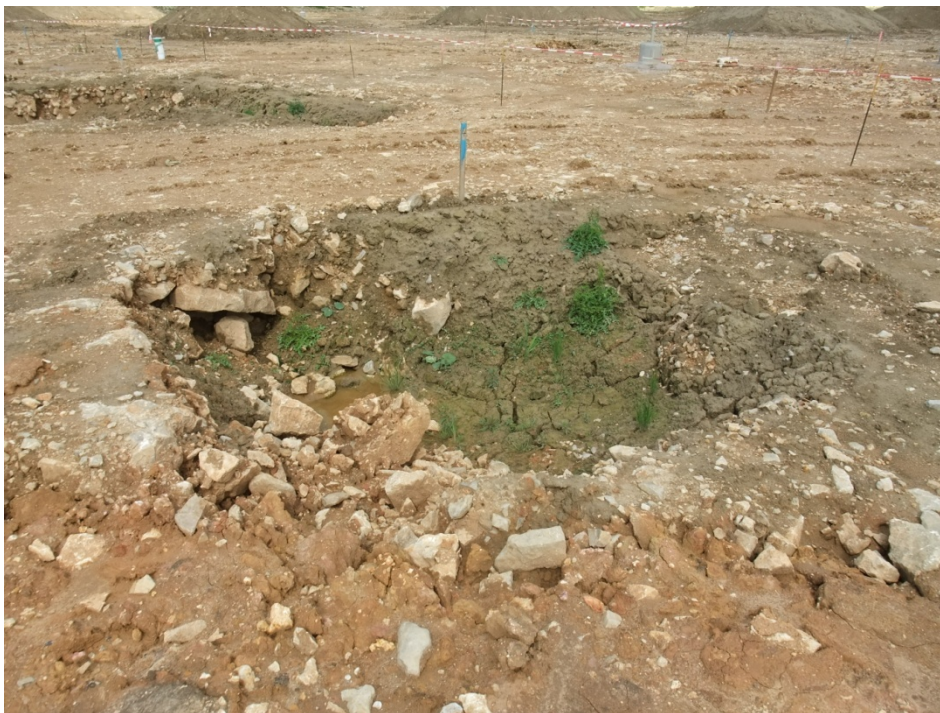
Bild 2: Blick von Süden auf Einbruchtrichter 2 vor Beginn der Schürfarbeiten
