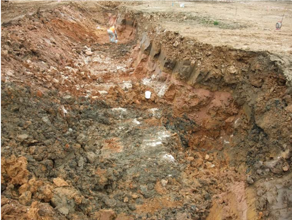
Bild 25: Block von Nordosten in den Großschurf, im Vordergrund rechts der freigelegte und teilweise ausgekofferte Einbruchrichter 4
