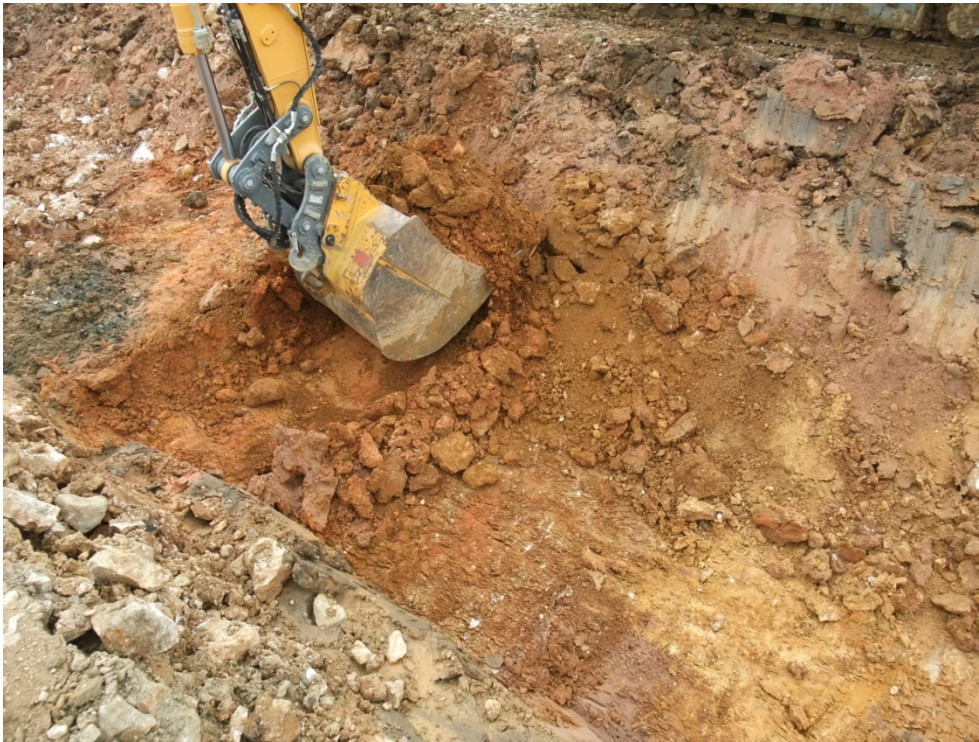
Bild 13: Aushub im Bereich des Großschurfes: große Bereiche mit Lockergesteinssedimenten (schluffige Sande und Schluffe) bröckelig-lockerer Zusammensetzung
