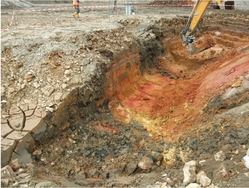
Bild 43: Aushub -3,0 m, Blick über den Einbruchrichter 1 (im Vordergrund), auf den Schurf mit den Einbruchrichtern 3 und 17 (hinter Baggerschaufel): im Schurf kreidezeitliche Sedimente in Grundrissfläche und Wandungen
