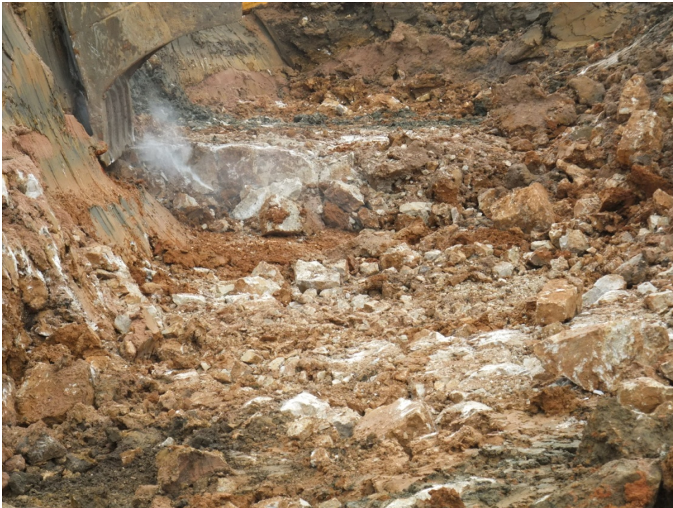
Bild 15: Lösen von Kalksteinformationen nördliche des Einbruch 2 bei einem Aushubniveau von etwa 2,5 m
