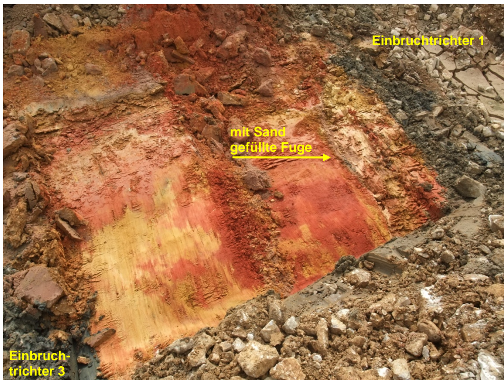
Bild 20 Abziehen des Filtersandes zwischen den Einbruchtrichtern 1 und 3: ocker-gelbe und kaminrote kreidezeitliche Sedimente (Detail Fuge siehe Bilder 23 und 25)
