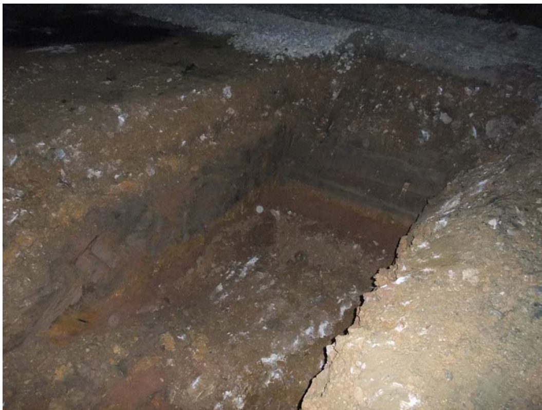
Bild 2: Schurf auf 1,4 m vertieft: planmäßig aufgebautes Dichtungssystem
