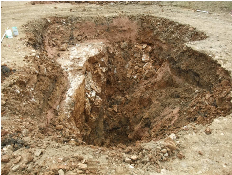
Bild 23: Großschurf am Einbruchtrichter 7 nach Abschluss der Schurfarbeiten (Blick nach Südosten)
