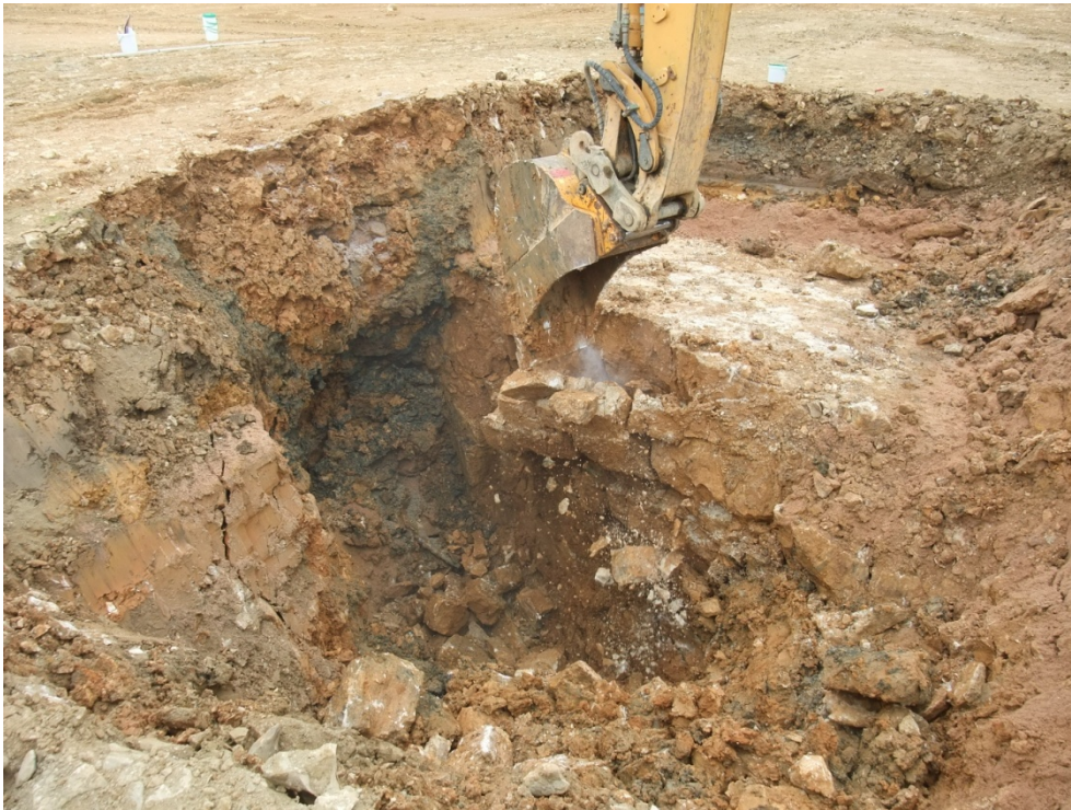
Bild 15: nachbrechendes Kalksteinmaterial
