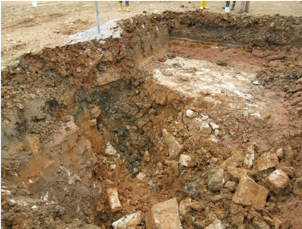
Bild 12: Einbruch 7 im Übergang einer Kalksteinformation zur Lockergesteinsfüllung der Versturzzone
