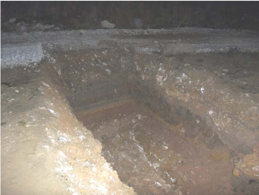
Bild 4: Schurf auf 1,4 m vertieft: im Hintergrund Fuß Ringdamm
