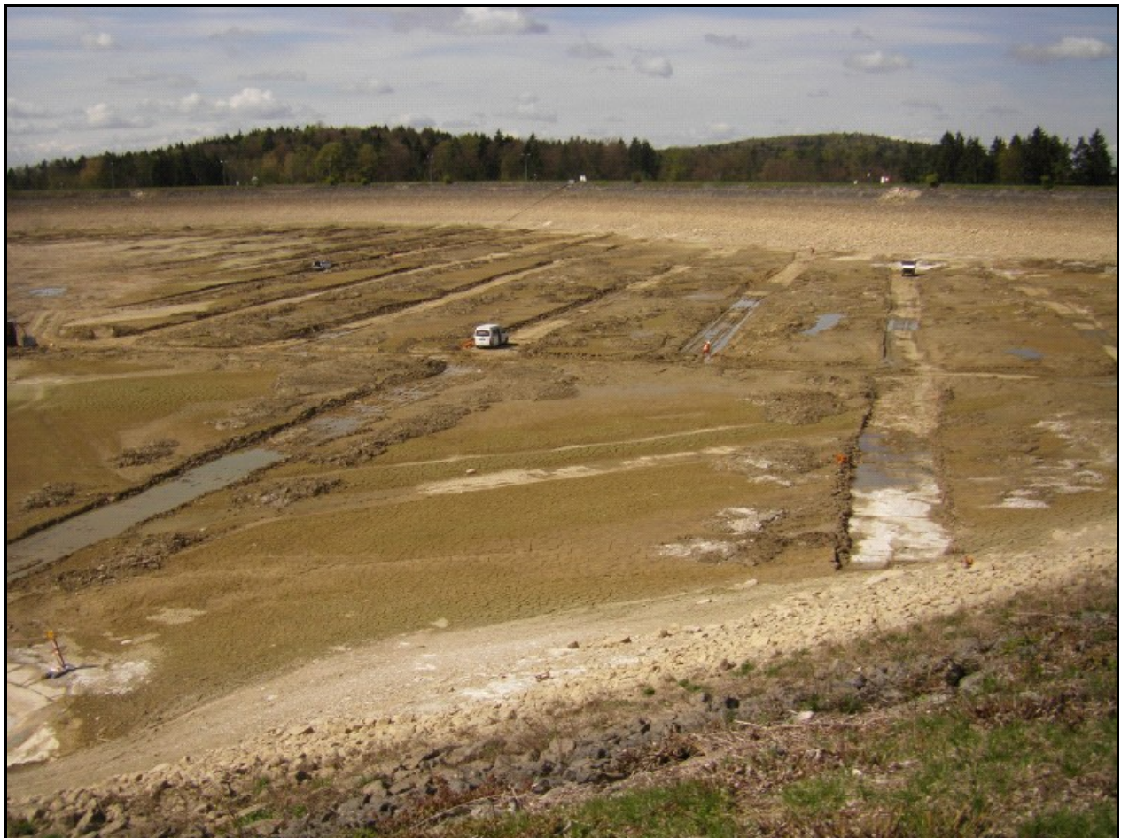
Abb. 2: von Sediment beräumte Messachsen im Becken
