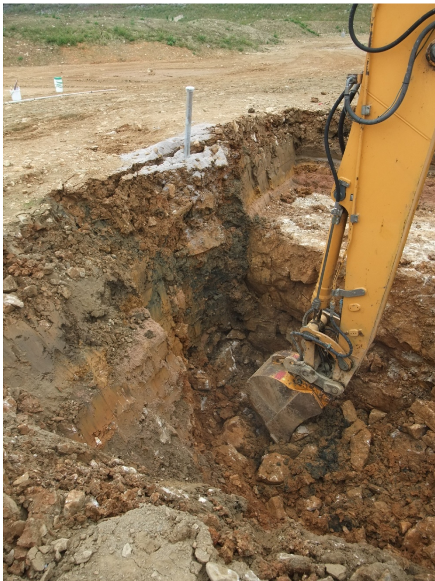
Bild 14: Weitere Vertiefung des Schurfs am Einbruchtrichter 7
