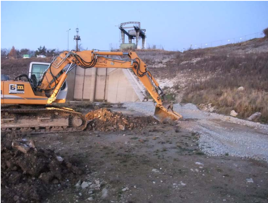
Bild 1: Blick von Süden auf Herstellung des Schurfs 10 m südlich von Einlaufbauwerk
