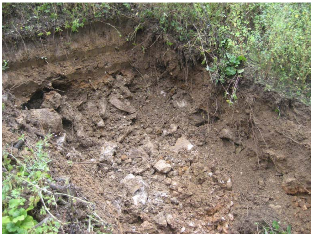
Bild 2: Aushubtiefe Schurf Nr. 01 bei ca. 1,0 m (aufgenommen am 15.08.2011)
