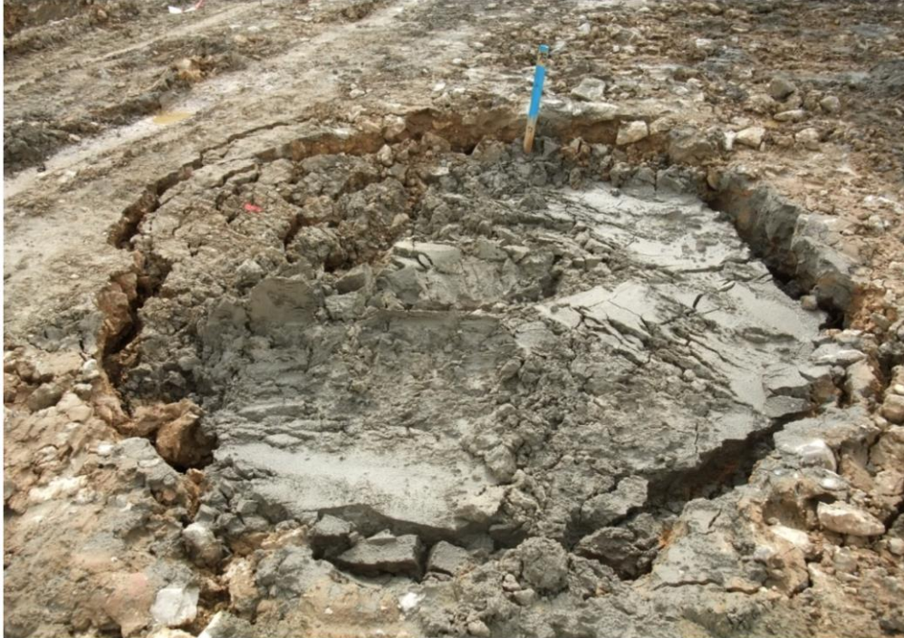
Abbildung 7: Im April 2011 eingetretener Einbruchtrichter ET 17 (Planfeststellung 2015)
