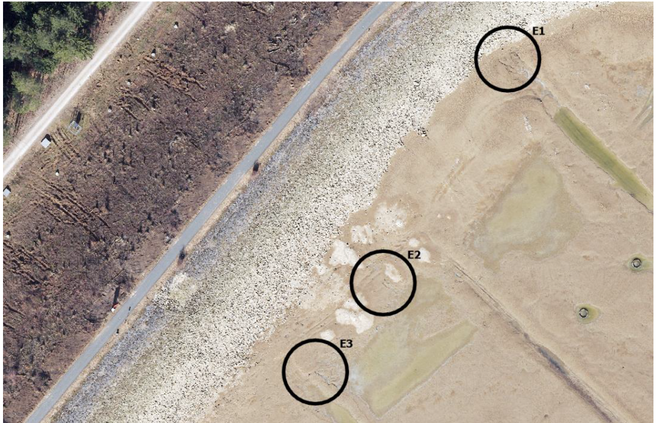
Abbildung 1 Lage der Erosionserscheinungen im Orthofoto von Anfang 2011
